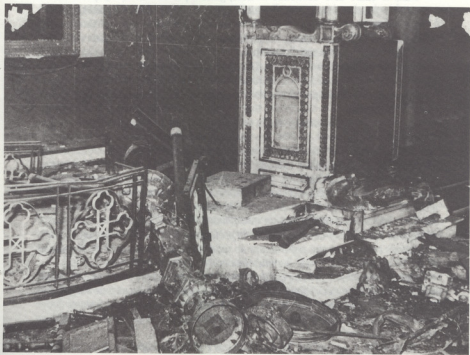
Une église grecque orthodoxe détruite pendant les émeutes anti-grecques des 6-7 septembre 1955.
